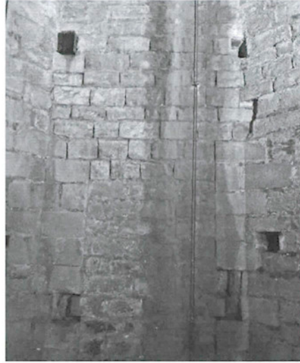
FIGURA 3: Detall d'una de les parets interiors del tercer pis del campanar, on s'observa el perfil d'un dels finestrals paredats
