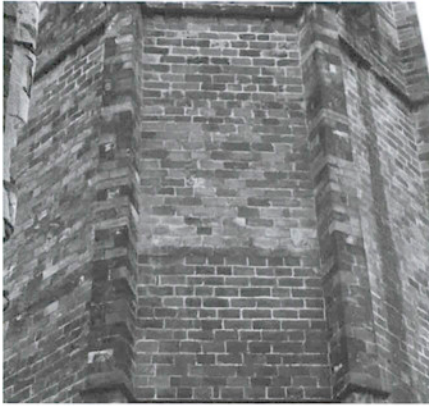
FIGURA 2: Detall del mur exterior d'una de les cares del tercer pis del campanar, on s'observa el canvi de parament
